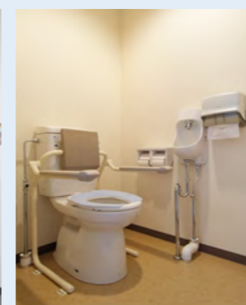
●手すり付トイレ
