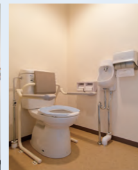
●手すり付トイレ
